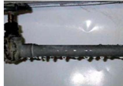
Kondensation von Feuchtigkeit an der Außenseite von Druckluftleitungen („Schwitzen“)
