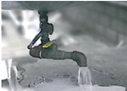
Bei unbehandelter Druckluft lässt sich die Ansammlung größerer Wassermengen im Luftkessel und in der nachgeschalteten Rohrleitung nicht verhindern.
