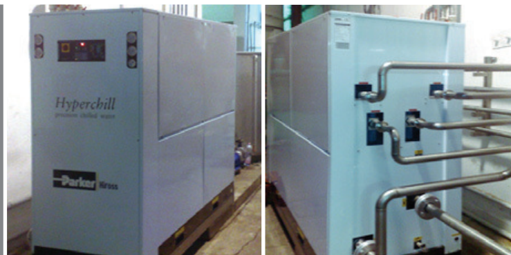
ICE76 wassergekühlt, außen vor einer Spirituosenproduktionsanlage installiert
